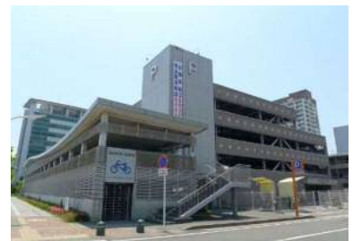
3. 清水駅東口駐車場
