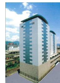
草薙駅前駐車場・草薙駅前西駐輪場 （敷地面積 857.6 m 2 ）
