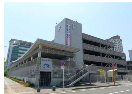
3. 清水駅東口駐車場
