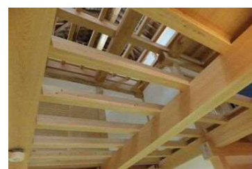
梁や屋根 (1階から見上げた様子)
