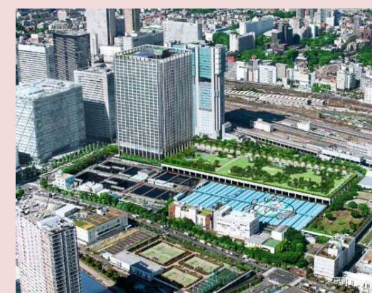
事例：芝浦水再生センター 東京都 下水施設上部空間を活用した事例
