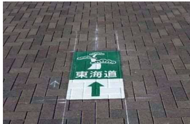
【写真 18】 路面シートによる旧東海道の歩道上の表示
