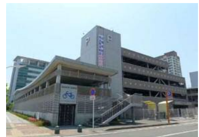
3. 清水駅東口駐車場
