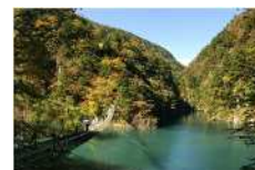
南アルプス麓の観光名所「夢の吊橋」 ▲
