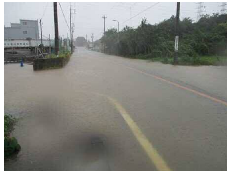
令和元年10月 台風19号（北街道線状況（大内地区））
