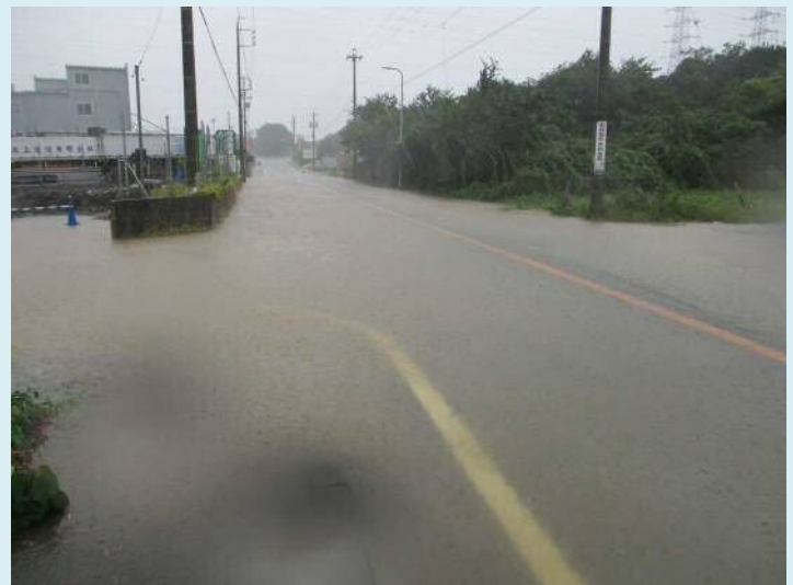
令和元年10月 台風19号状況(北街道線(大内地区))
