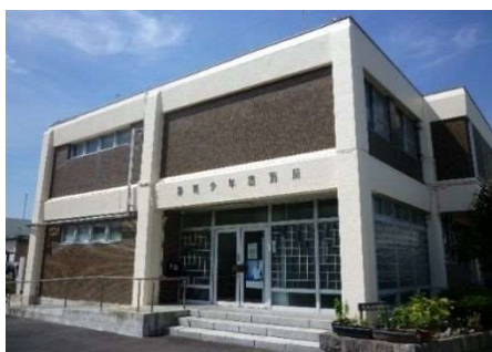
施設外観 所在地：静岡市駿河区小鹿二丁目27番7号
