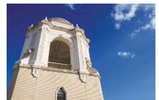
<市役所静岡庁舎本館>
