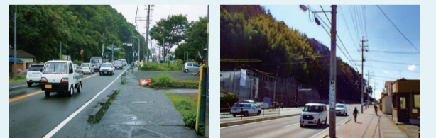
▲道路の拡幅工事前 ▲道路の拡幅工事後
