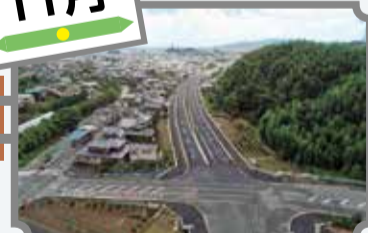
県道清水富士宮線バイパスが 部分開通(11/16)
