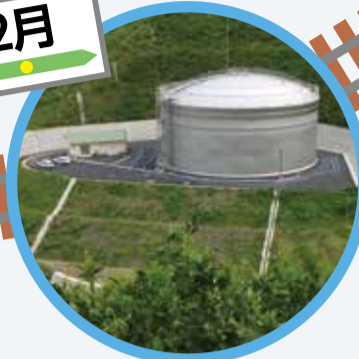
北部ルート・柏尾配水池完成(2/7)
