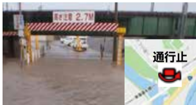
▲アンダーパスの冠水状況(清水区颯津)
