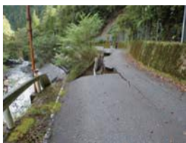
仙俣線(葵区口仙俣)
