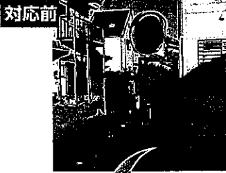
【下川原】カーブミラー改修
