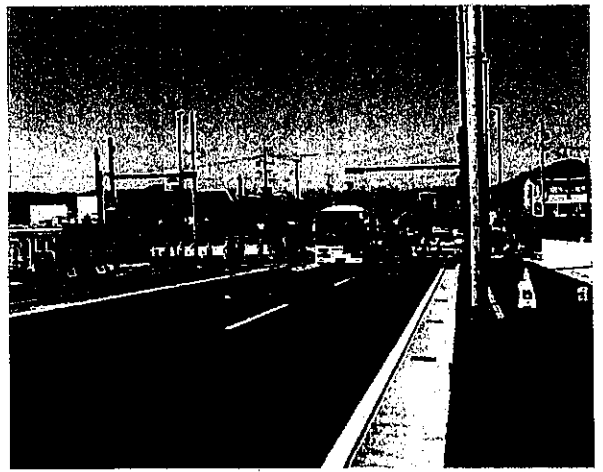
バイパス整備区間
