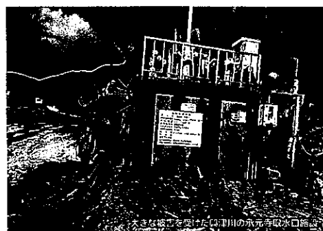
大きな被害を受けた静岡市川原の浄土寺取水口跡
