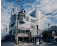
「北部勤労者福祉センター」(ラパック静岡) 所在地: 静岡市葵区本通7丁目 11-9
