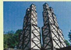
葦山反射炉 (伊豆の国市 国指定史跡)
