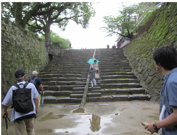
図 34 見学者用に新たに設置した石段（熊本城）
