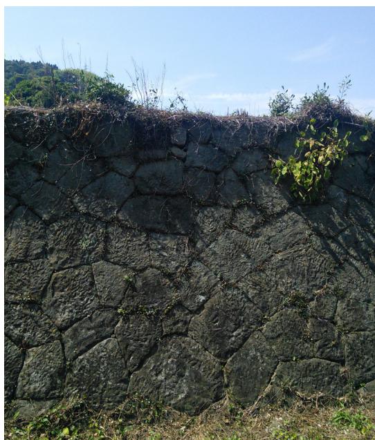
図30 御殿脇の切り込み接ぎの石垣
