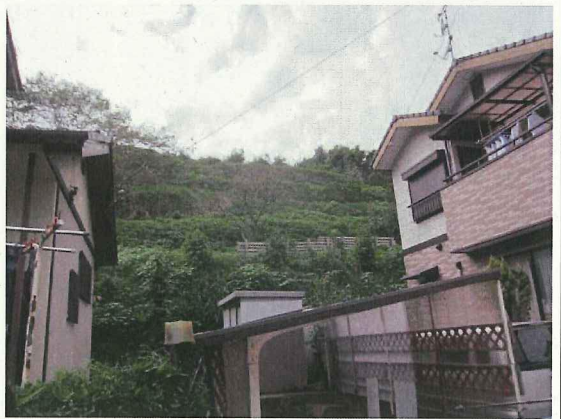
12 第2郭東側の崖地を宅地側から見上げる
