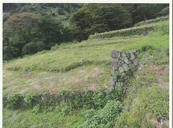
4 第2郭の侍屋敷推定地、傾斜地が段々畑のように石垣で区画される
