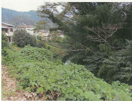
21 別当沢沿いの崖地、樹木や草が繁茂する
