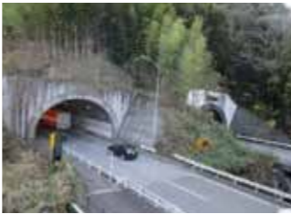
平成のトンネル (国道1号下り)
