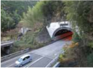
昭和のトンネル (国道1号上り)
