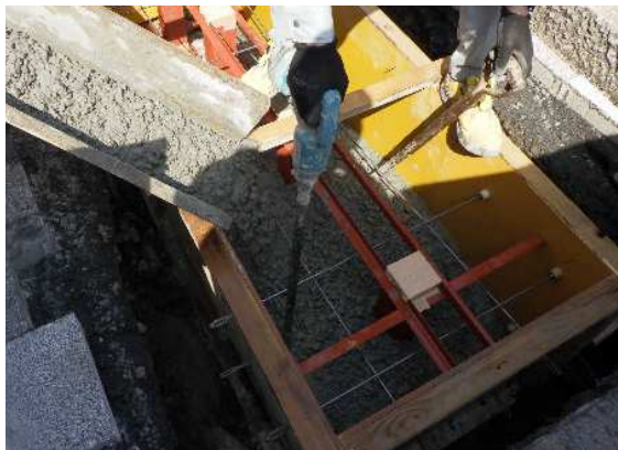
JISに基づき調査されたコンクリートの搬入とコンクリートの打込み
