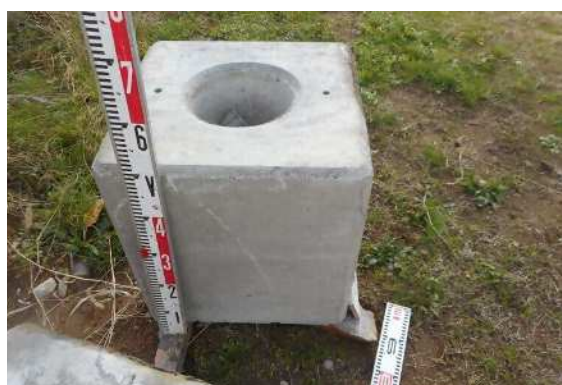
事前に打設された屋外広告物の基礎
