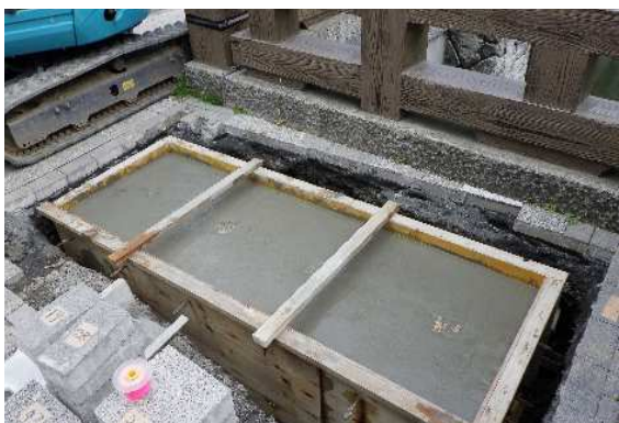
手作業によるコンクリートの打ちみ
