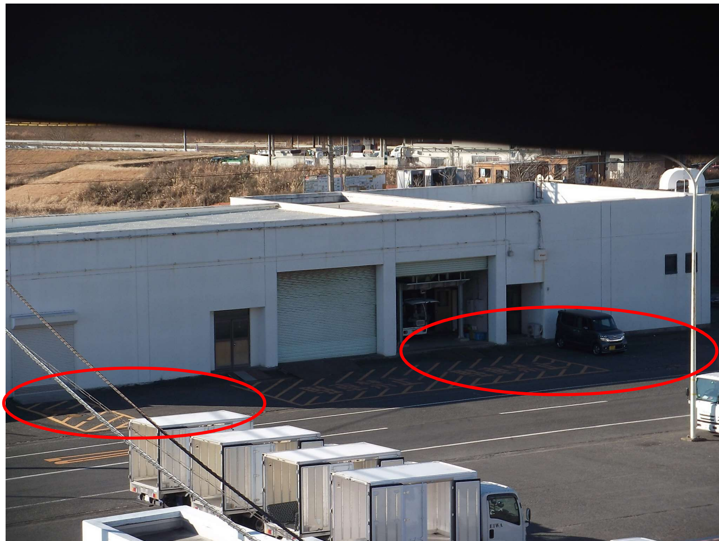
汚水処理棟前駐車場（赤く囲んだ部分に駐車してください。）
