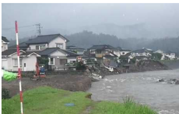
河岸侵食による家屋の倒壊(花月川)
