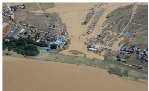
堤防決壊による家屋の流失(鬼怒川)
