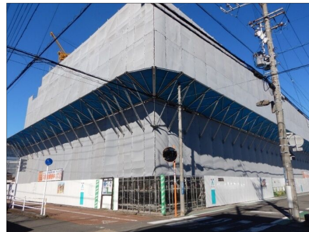
建設中写真（令和3年2月頃）
