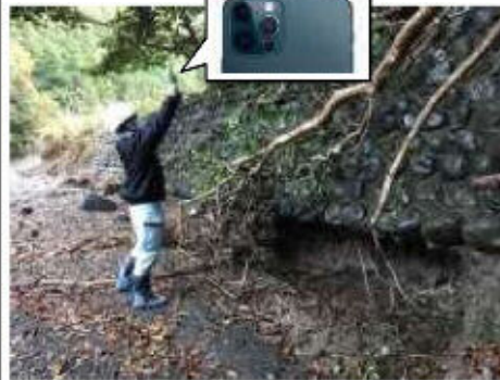
職員によるタブレット端末での点群計測
