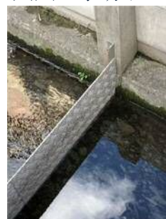
側溝に板をはめる仕掛け
