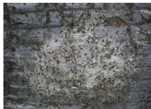
図 4-1 排水溝の蓋の裏に大量に生息しているユスリカ
