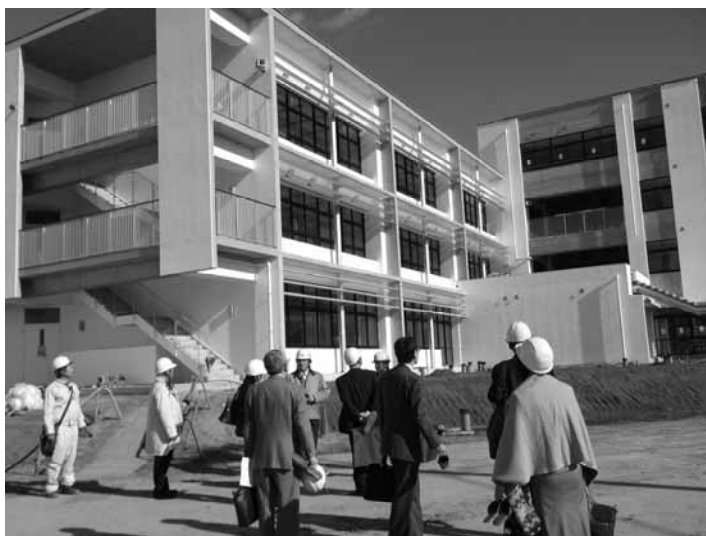
清水桜が丘高校の校舎建設現場を視察
