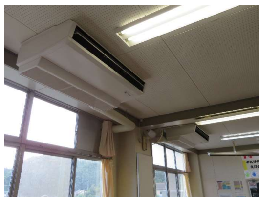
設置が完了した教室
