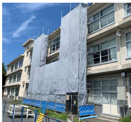
設置工事中の学校
