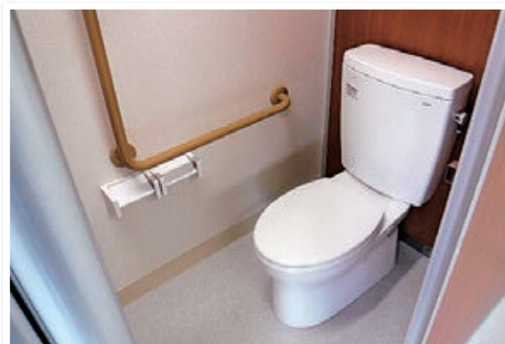
小学校校舎の改修後のトイレ
