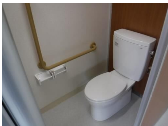
改修後のトイレ
