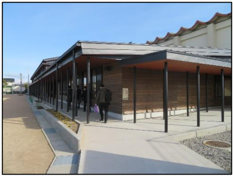
A【木のぬくもりの外装と外からのアクセスのイメージ】 (参考：魚津市星の杜小学校)
