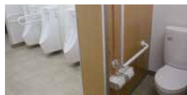
改修後のトイレ
