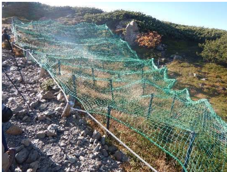
中岳避難小屋周辺防鹿柵
