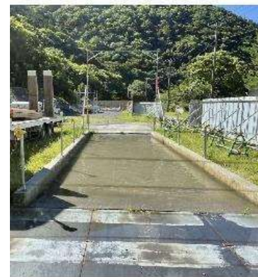
写真 タイヤ洗浄プール (JR東海提供)
