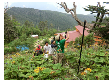
防鹿柵の設置
