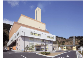
西ヶ谷清掃工場
