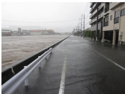
図表 38 平成26年台風18号による 浸水の様子（静岡市清水区江尻台町付近）
