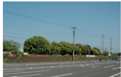
城北下水道処理場
