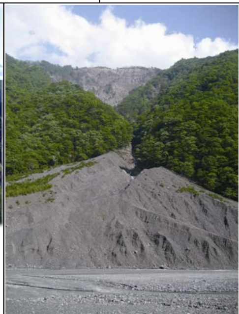
赤崩の斜面崩壊
