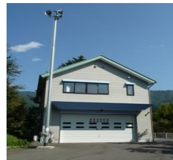
<千代田消防署井川出張所 (静岡第35分団合築) 庁舎>
