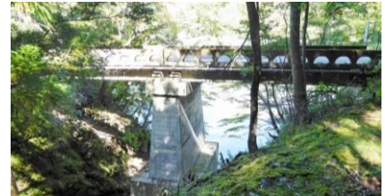
<赤土沢橋 (耐震化完了)>
