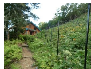
防鹿柵の設置状況
