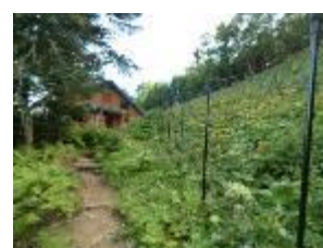
防鹿柵の設置状況
