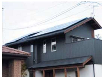
家庭においては、省エネ機器への転換や太陽光発電の設置が進んでいる。
