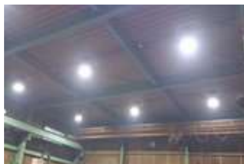
LED照明 改修後
