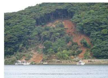
長崎県上五島町の台風に伴う土砂災害 出典：気象庁HP 「災害時自然現象報告書 (2020年第1号)」
