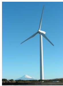
風力発電施設「風電君」
