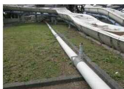
写真2：露出配管
