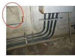
写真1：地下ピット内部
